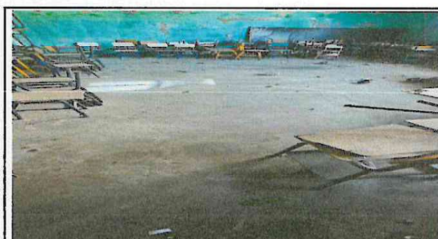
Foto 4: Instalación de piso de granito
