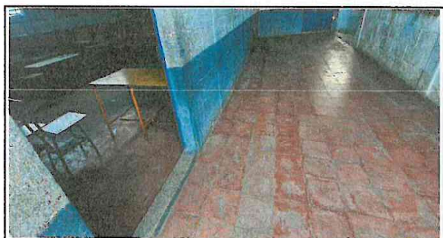
Foto 3: Instalación de piso de granito
