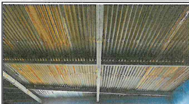
Foto 2: Sustitución de lamina acanalada por lamina troquelada
