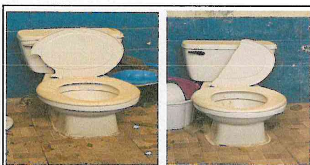
Foto 6: Remozamiento de sanitarios
