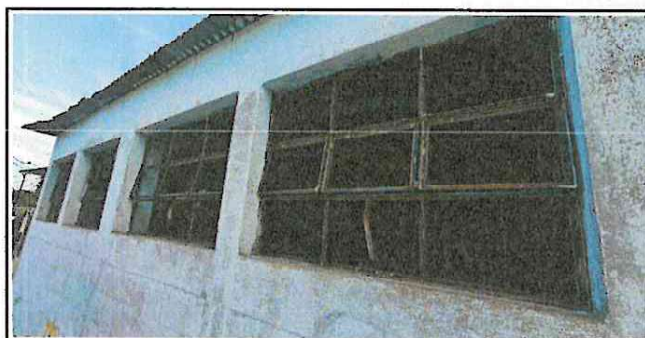
Foto 5: Remozamiento de ventanas
