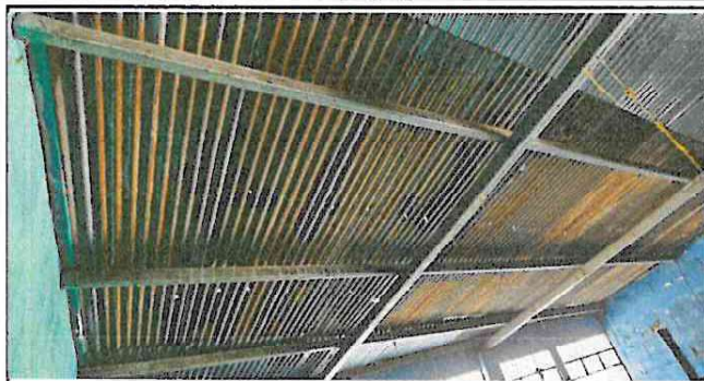
Foto1: Sustitución de lamina acanalada por lamina troquelada
